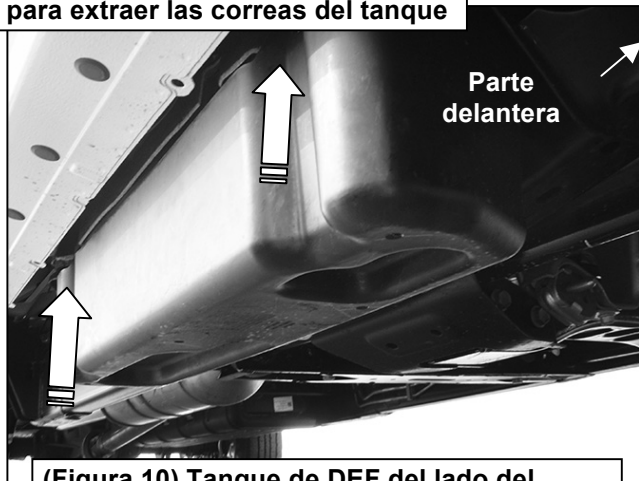
(Fig. 10) Tanque de DEF del lado del pasajero y cubierta
